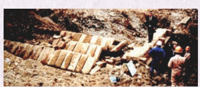
▲足柄大橋工事中に発見された取入口跡
