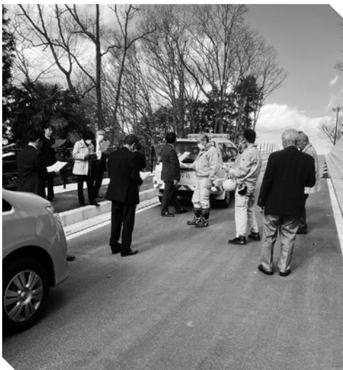
道水路改良工事（町道501号線）
