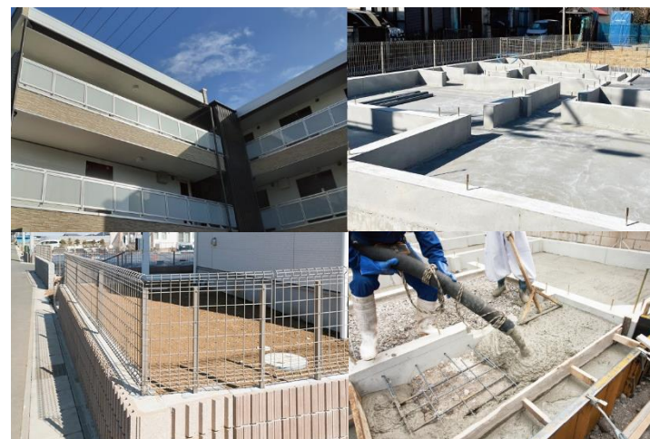
基礎工事及び外構工事の施工事例
