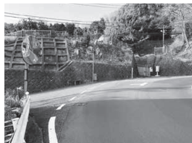
道幅が狭い町道4号線
