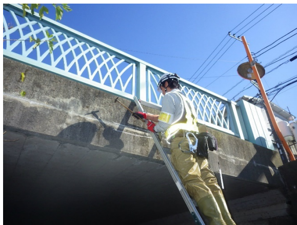
写真6 1 橋りょう点検状況
