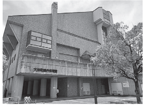
雨漏り修繕が急務となった総合体育館
