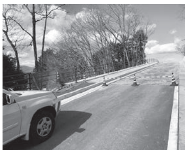
開通予定の集落間道路（町道501号線）
