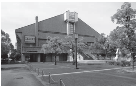
大規模改修が予定されている総合体育館
