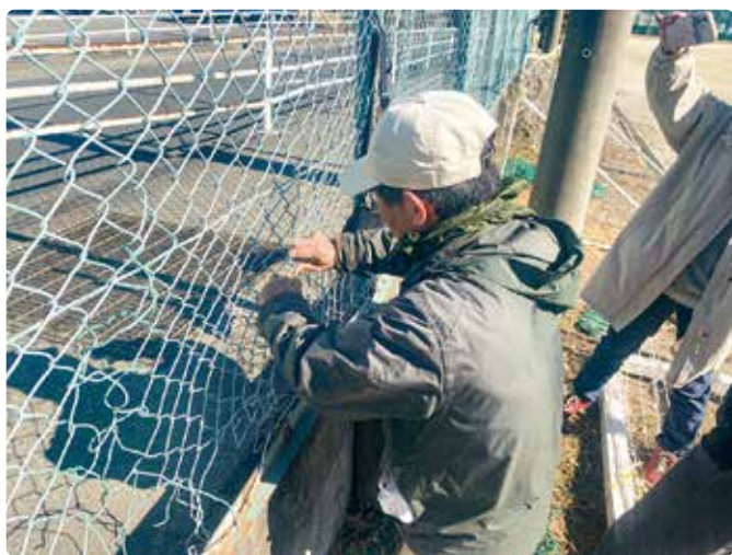
手際よく学校のフェンスを修理するMさん
