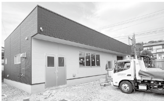
建設中の第1分団待機宿舍
