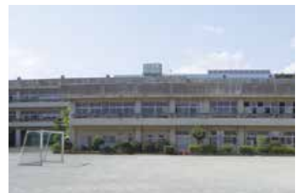
上大井小学校の改修工事
