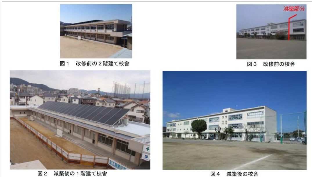
左：滋賀県大津市（2階部分の撤去による減築）、右：和歌山県有田市（使用頻度が低い棟の減築）
