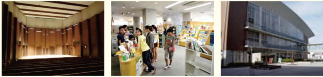
左：音楽ホールを含む区立文化センター等との複合化（品川区立第一日野小学校） 中央：児童書コーナーを広く設けた市立図書館等との複合化（志木市立志木小学校） 右：競技用のバスケットボールコートをもつ2面有する体育施設との複合化（かほく市立宇ノ気中学校）
