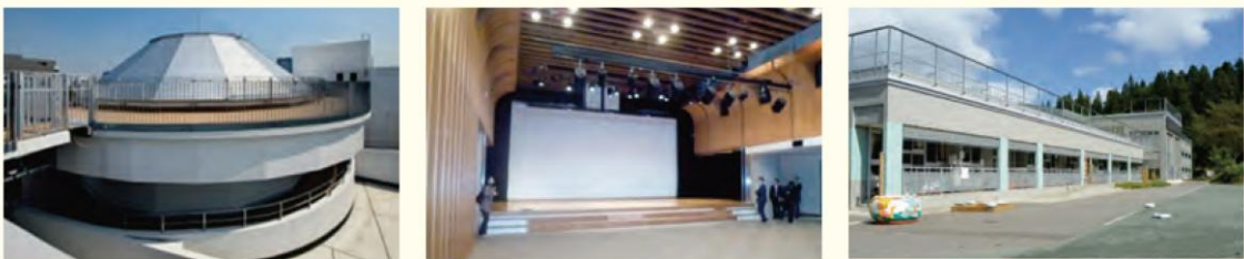
左：幅広い年代に利用されている文化センターのプラネタリウム（品川区立第一日野小学校） 中央：地域の生涯教育・交流活動の拠点となるホール（南砺市立利賀小中学校） 右：小・特別支援学校、発達支援センターが併設する地域特別支援教育施設（十日町市立十日町小学校）
