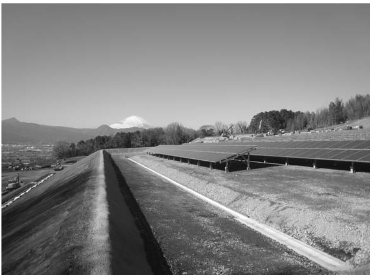
ソーラーパネルが次々と設置されていく
