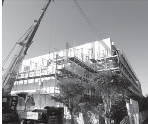
改修の進む湘光中学校
