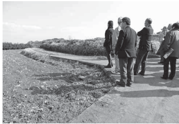
農業用道路舗装工事 (赤田)
