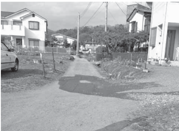
町道148号 道路改良工事 (坊村)
