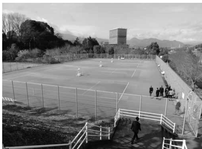
山田総合グラウンド 人工芝テニス コート張り替え工事 2,408万円
