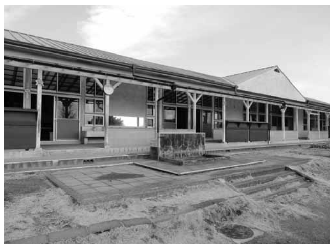
大井児童コミュニティクラブ トイレ、床、建具改修工事 1,415万円
