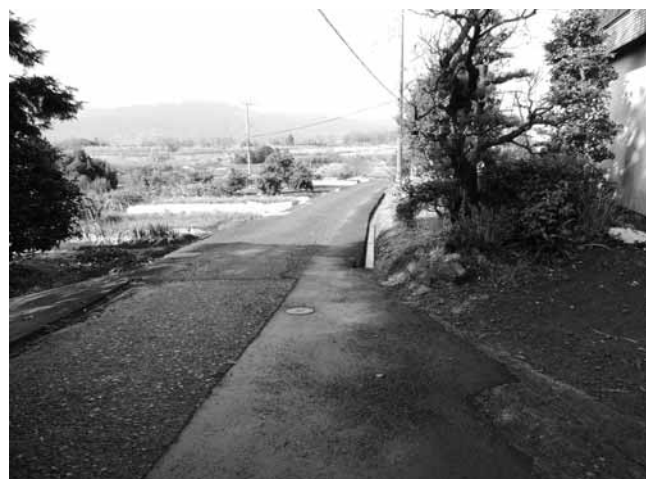
道路改良工事 6件 9,440万円 写真は、町道518号(下山田地内)
