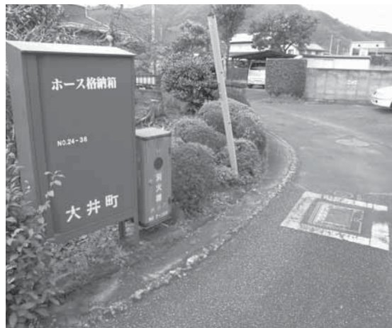
100m以内に設置されている消火栓とホース格納箱
