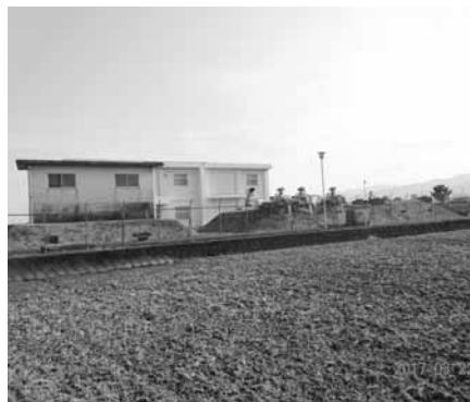
改修が予定される浄水場
