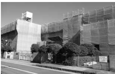
改修工事がはじまった上大井小学校
