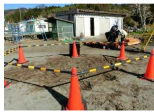
てこの原理でコンクリートつきの古い丸太を撤去
