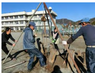
てこの原理でコンクリートつきの古い丸太を撤去
