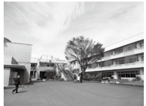
改修工事が始まる大井小学校
