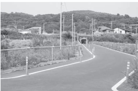
都市計画道路工事中の交通安全は守られるのか？
