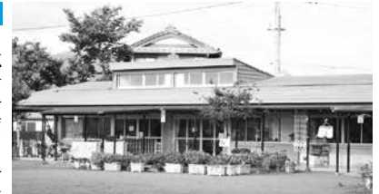
築44年経過している 大井第2幼稚園
