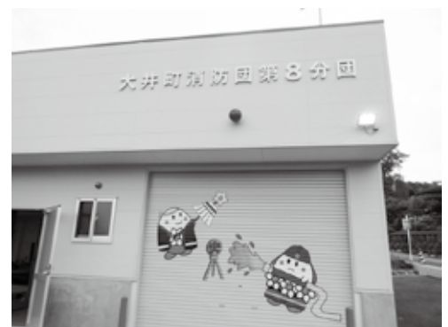
新築された詰所
