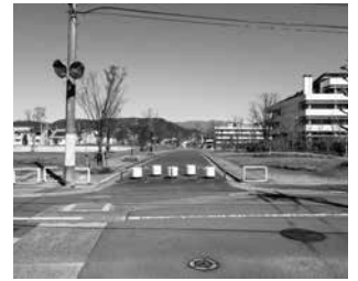
当面の開通を見送る （仮称）新湘光公園沿い道路
