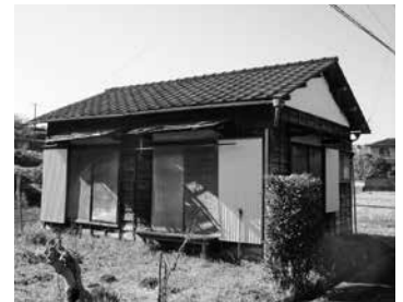
取り壊し予定の空き家 町宮大縄住宅(下山田地内)
