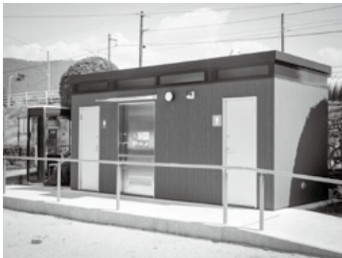
新築された相模金子駅前公園トイレ
