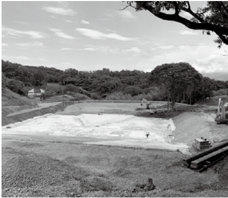
工事が進む人工サーフィン場
