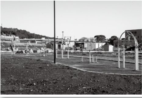
▲建設工事も順調に進んでいます。 (写真は健康遊具)
