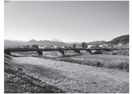
店屋場堤から見た川音川
