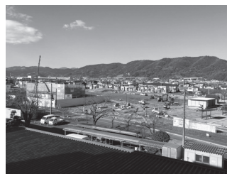
建設中の防災倉庫（左）と大井中央公園休憩所（右）
