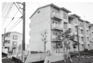
町営河原住宅屋根改修を実施します。
