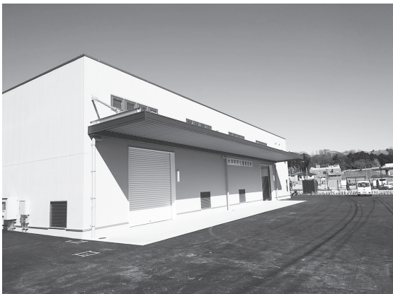
新設された防災備蓄倉庫
