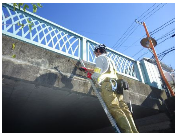
写真6 1 橋りょう点検状況
