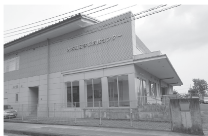
大井町立学校給食センター
