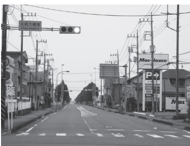
無電柱化に取組む予定の 県道711号線 (緊急輸送道路)
